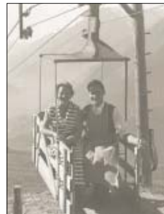
Von der Materialeilbahn... (i. B. Karl Gamper mit einem Gast)
